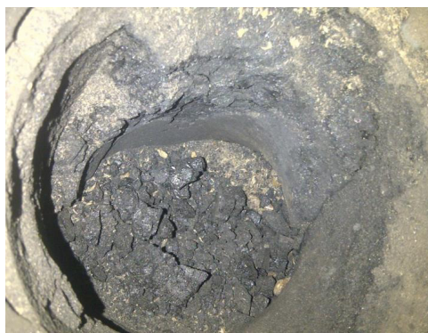
Nagar vznikl při spalování pelet - pohled na retorty shora
